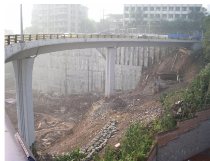
图 4 F 匝道桥及邻近基坑
